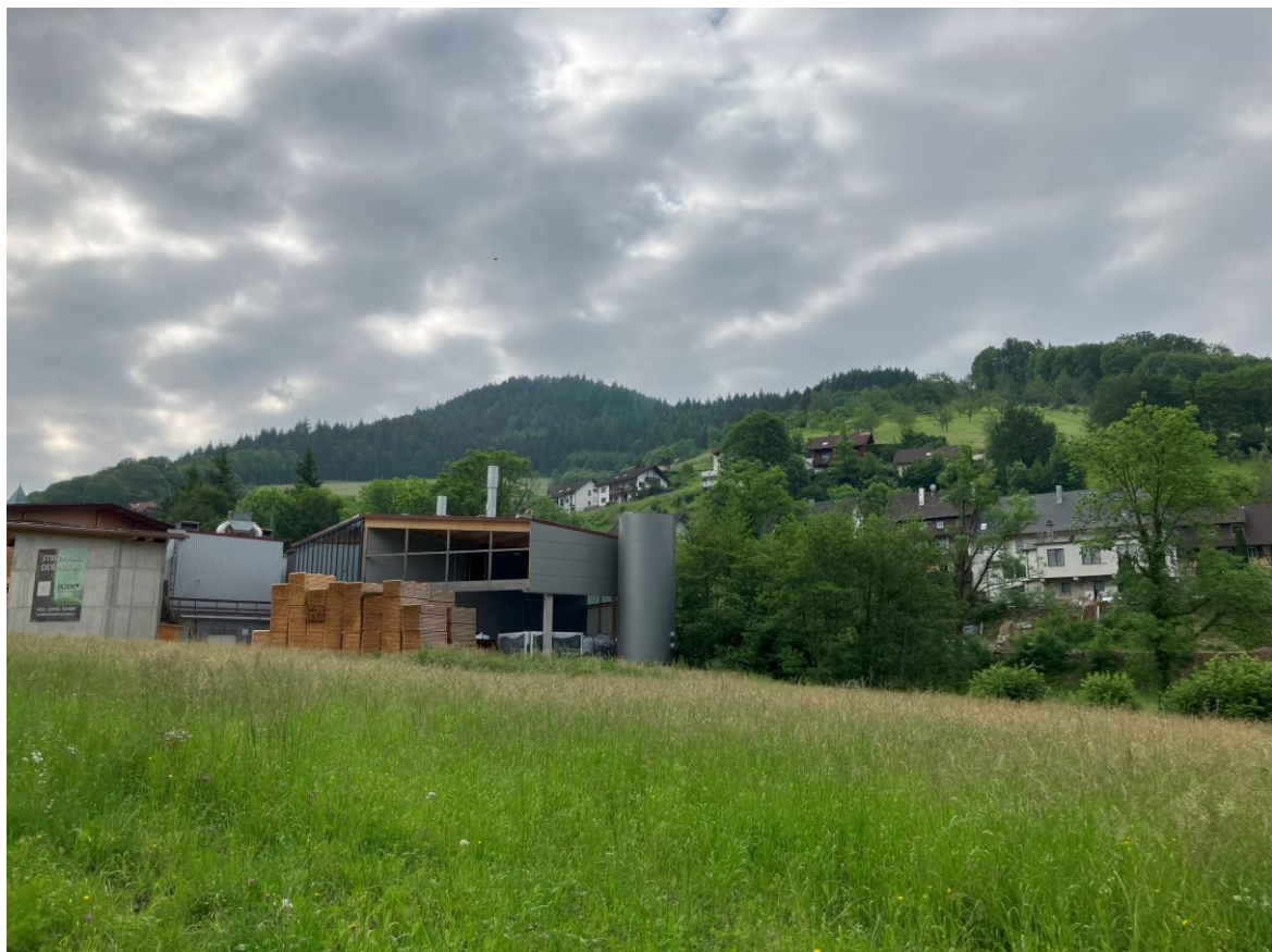
Abb. 12: Blick auf Plangebiet in südliche Richtung; vorhandene Bebauung des Sägewerk (eigene Aufnahme)
