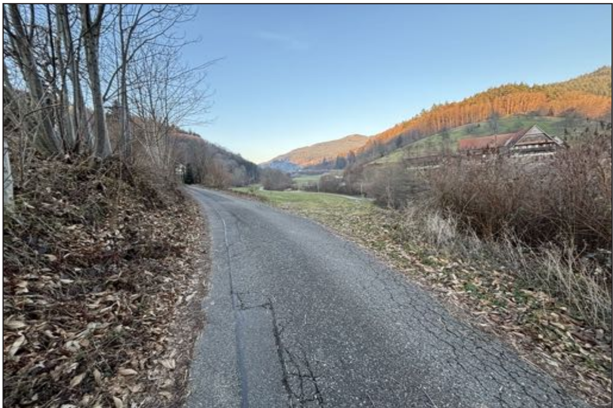
Abbildung 9: Hagenbruck. Blick in Richtung Norden.
